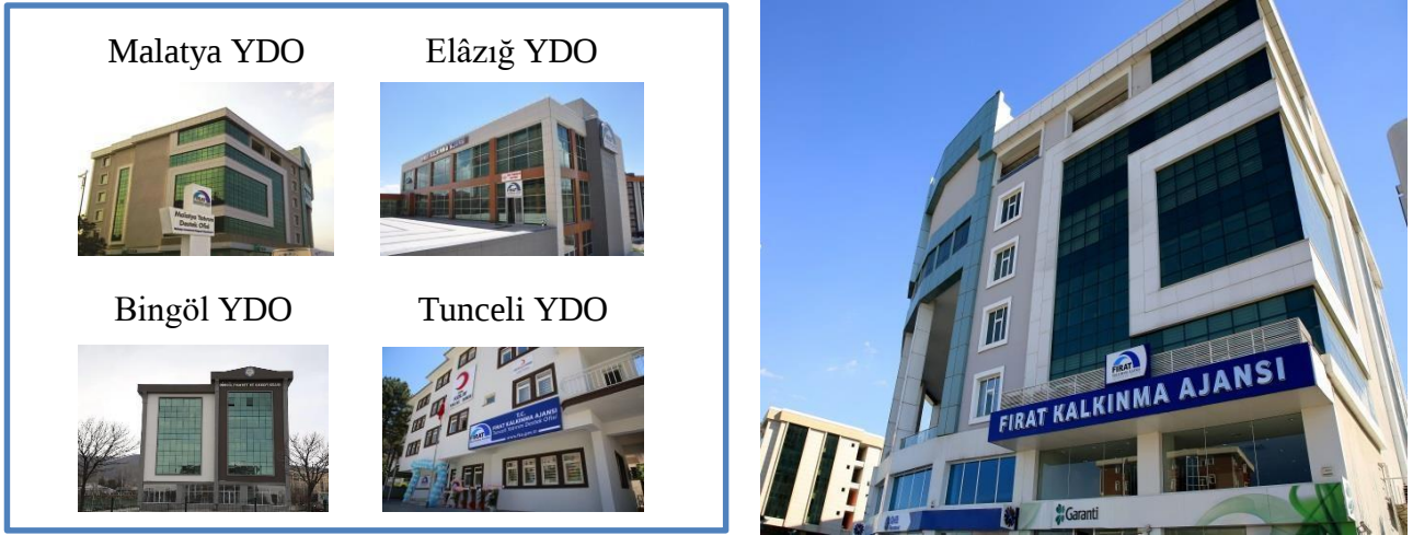
Şekil 1: Firat Kalkınma Ajansı Merkez Binası ve Yatırım Destek Ofisleri
